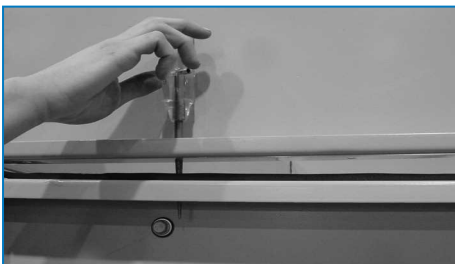
Verwendung des Treibdorns zur Ausrichtung der Schraublöcher
